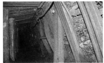
图1 3403上平巷原锚网索支护
