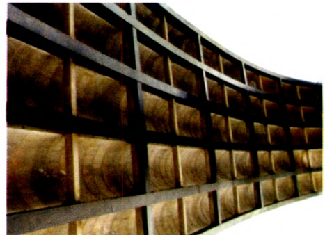
图 5 粘贴钢板加固外观
