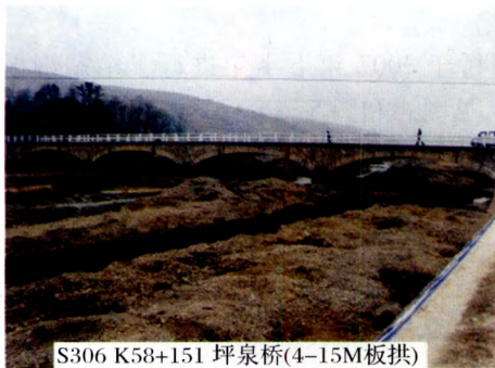
图10 坪泉桥震时发生严重破坏
