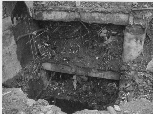
照片一 舊地下室內部回填情況
