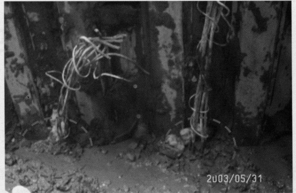
照片九 施作P3單元時出露之殘留鋼筋混凝土樁
