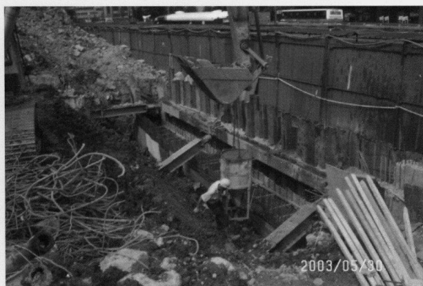
照片六 導牆澆灌混凝土
