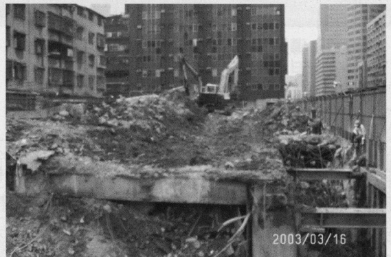
照片二 破碎舊地下室及架設水平支撐
