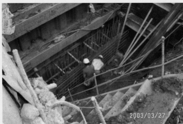
照片四 導牆鋼筋綁紮
