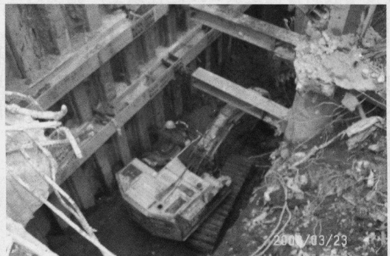
照片三 舊地下室基礎下開挖
