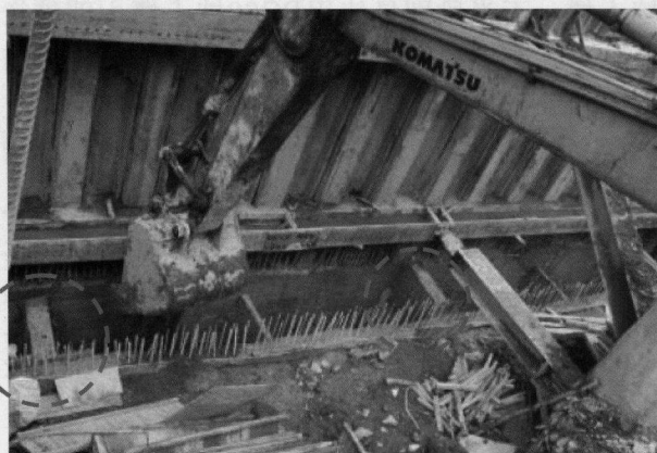
照片五 導溝分段施作無筋混凝土隔牆及回填
