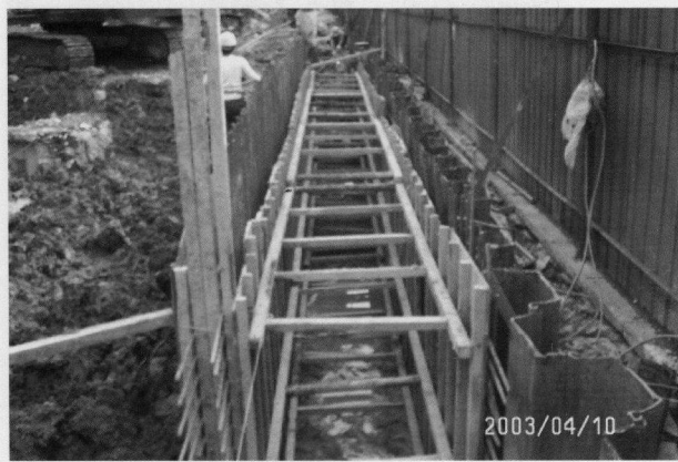
照片七 最上一層導牆之施作情形
