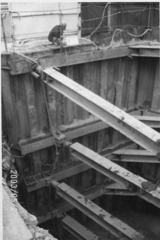
照片八 開挖至預定深度及完成支撐架設
