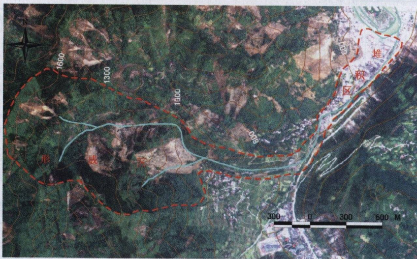
图 6 西山坡泥石流沟流域航空影像图
