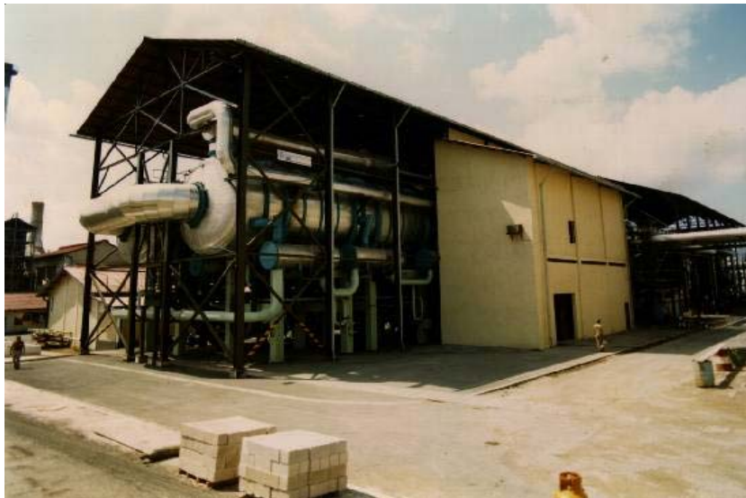
Fig. 3. LT MED 10,000 m 3 /d + 3.2 MW.
